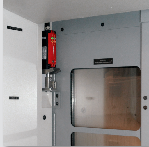
Absicherung einer Schiebetüre
