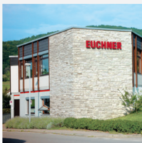
Site de production Unterböhringen
