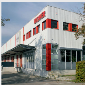
Logistické centrum Leinfelden-Echterdingen
